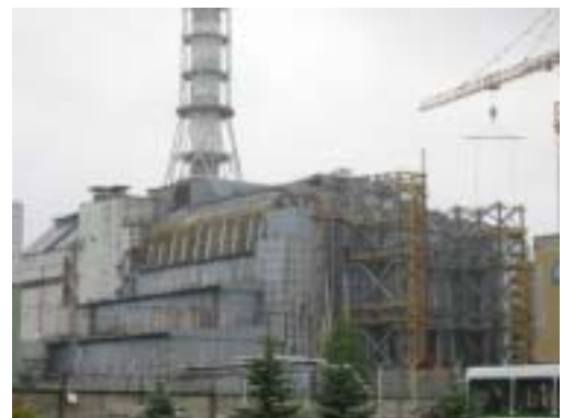
写真4 チェルノブイリ原発4号機の外観
