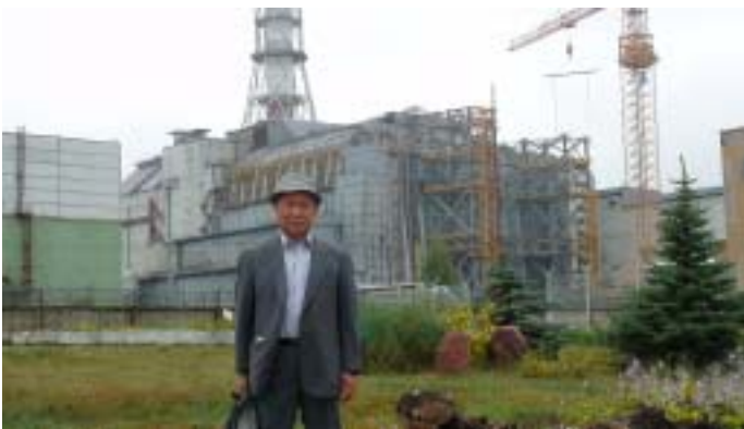
写真3 チェルノブイリ原発4号機の外観
