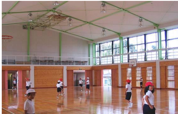
耐震化工事の終了した仲町小学校屋内運動場
