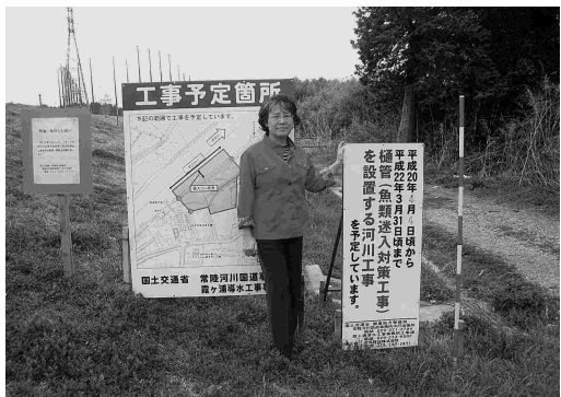
那珂川の取水口工事予定地(水戸市渡里町)
