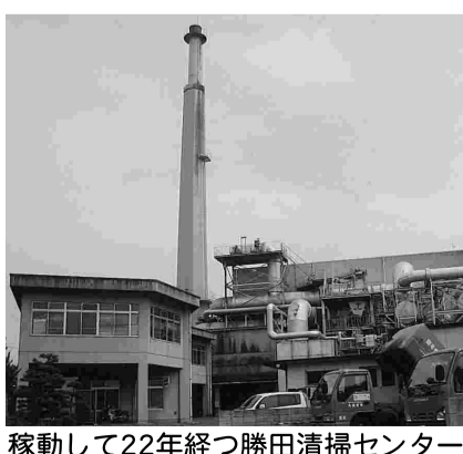
稼動して22年経つ勝田清掃センター
