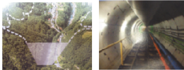
ハッ場(やんば)ダム予定地(群馬県 国交省パンフより) 霞ヶ浦導水事業のトンネル内(国交省パンフより)
