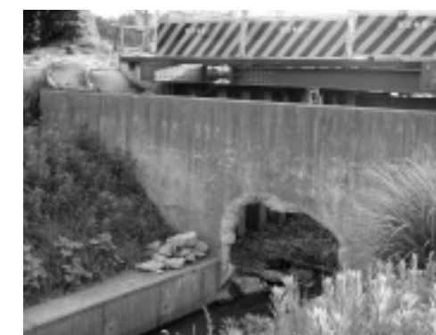
陥没の被害があらわになった西部排水路
