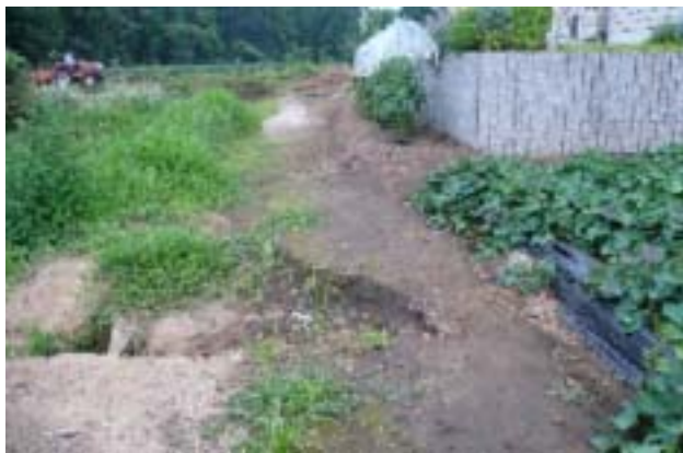
真ん中の農道から崩落している
