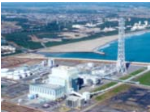
東電常陸那珂火力発電所
