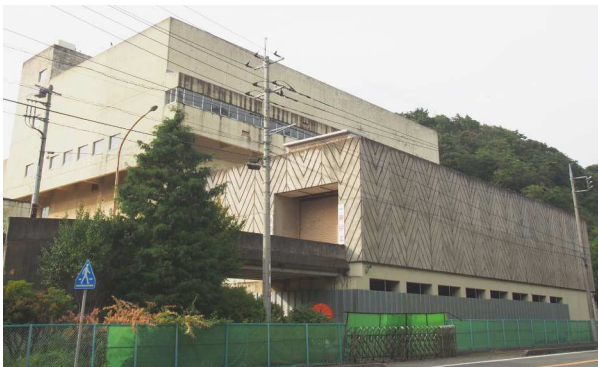
旧清掃センター内の廃棄物保管場所（右手前）
