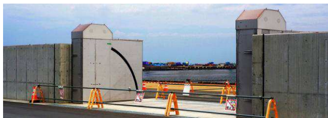
整備中の防潮堤と流入する海水圧で自動閉門する陸閘
