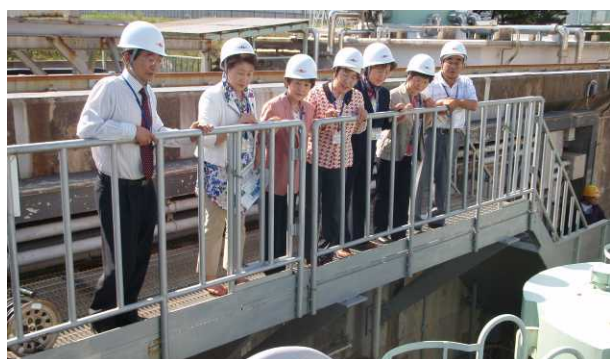
水没した非常用発電機の海水ポンプ付近
