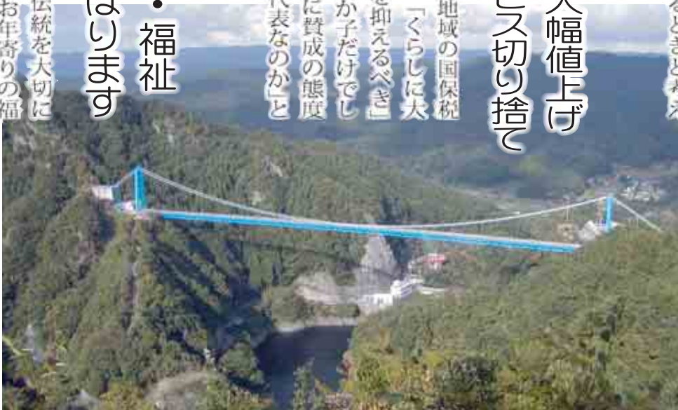
龍神大吊り橋
