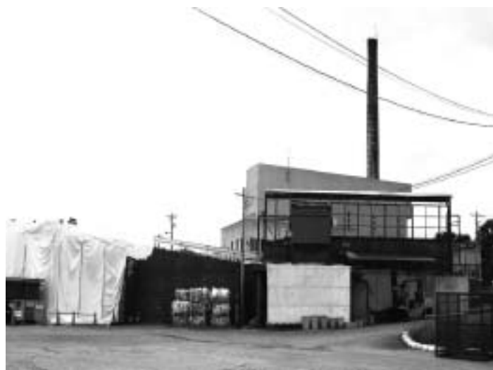
解体工事が進む北部衛生センター
