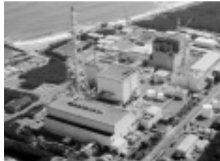
東海第二原発(手前)と廃止措置中の東海発電所(奥) 西日本新聞より
