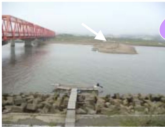
長く伸びて半島化したように砂が堆積 (向こう岸が日立市)
