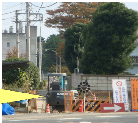
村道3038号の舗装 始まる (白方)
